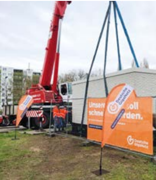
Die Verteilerkästen in Odenkirchen und Wickrath sind bereits aufgestellt. FOTO: DEUTSCHE GIGANETZ
